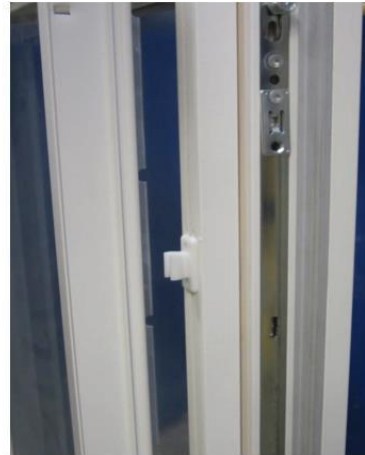
Vid sammankoppling av koppelbeslag, tryck aluminiumbågen mot träbågen.
